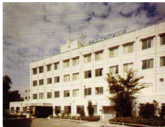
旧大阪掖済会病院（昭和49年～平成17年）本館
